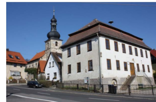
Bild 2 – Zehnthaus vor der Sanierung im Jahr 2010
