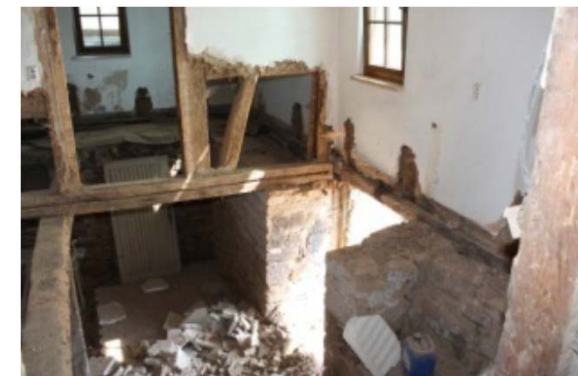
Bild 5 und 6 – Schwamm- und Schädlingsbefall erschweren die Arbeiten
