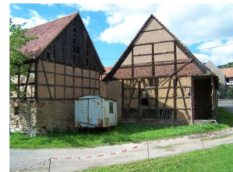
Der Vierseitenhof vor der Sanierung
