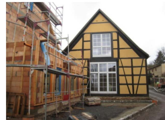
Der Vierseitenhof während der Sanierung
