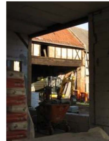
Bauarbeiten am Innenhof
