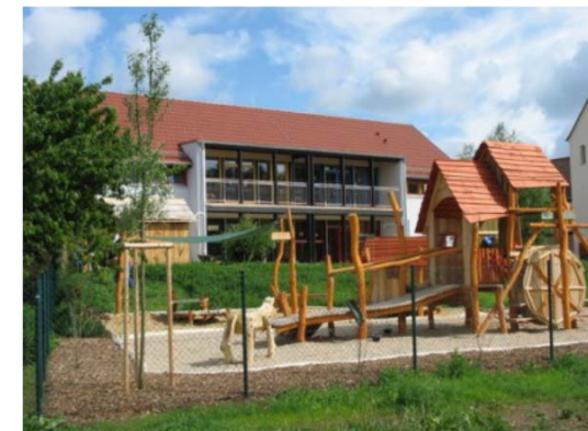
Der Vierseitenhof nach der Sanierung
