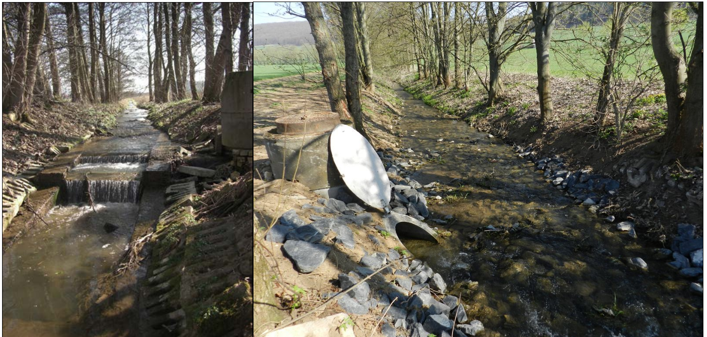
Bilder 1 und 2: Einlaufbauwerk mit Abstürzen vor dem Rückbau und Gewässerabschnitt danach (Quelle: LPV)
