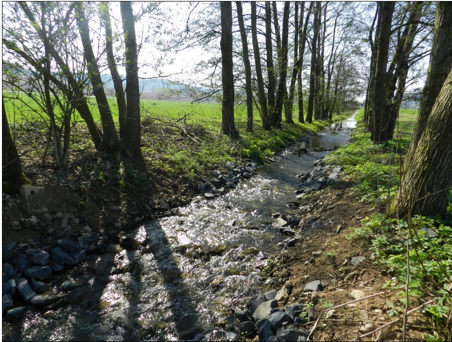
Bild 3: Gewässerabschnitt nach der Projektumsetzung (Quelle: LPV)
