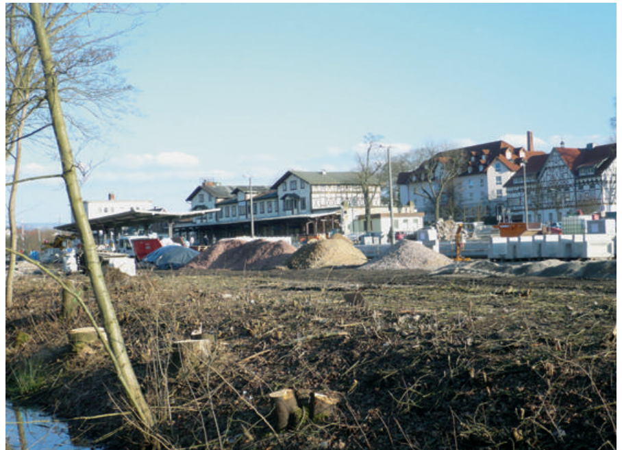
Abb. 2: Bauarbeiten am Bahnsteig inklusive angrenzendem Parkplatzbau, Stand Februar 2015. (Aufn. A. HECK 26.02.2015)
