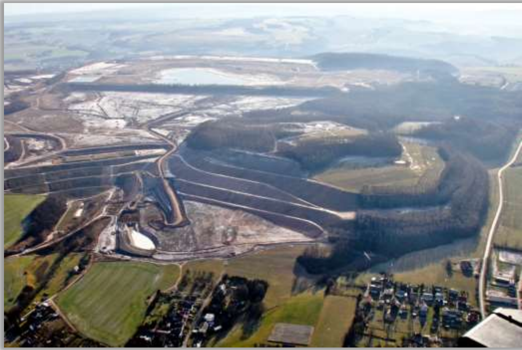
IAA Culmitzsch mit Waldhalde (durch Abtrag freigelegte Aufstandsfläche im Vordergrund), Januar 2012, Foto: TLBA
