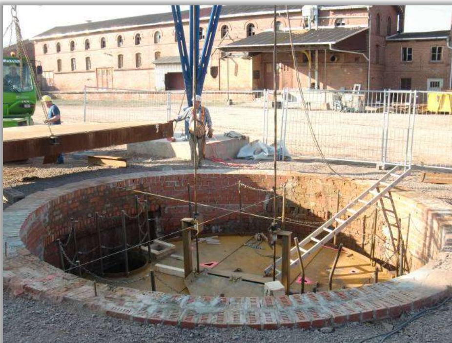
Fertiggestelltes Schachtgerüst
