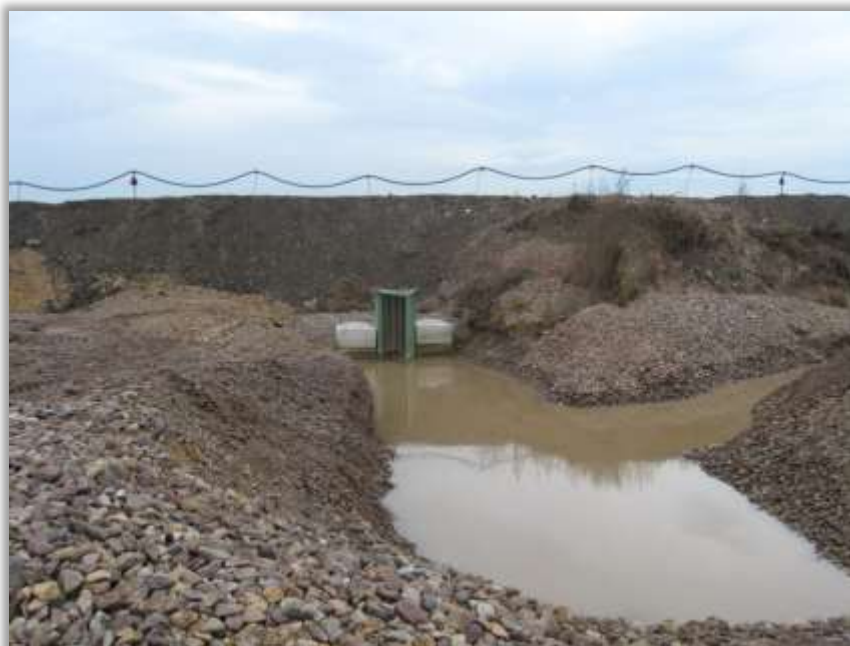
Ausbau Klingegraben und Überlaufbauwerk in den Klingegraben
