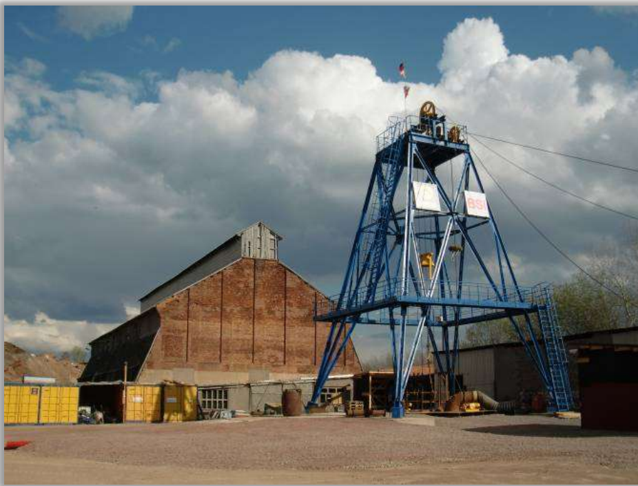
Fertiggestelltes Schachtgerüst
