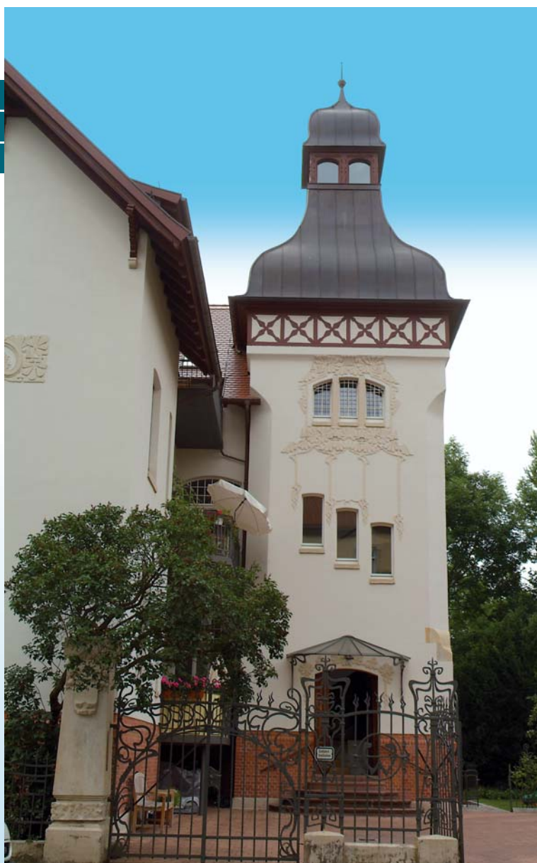
Trotz des wehrhaften Turms eine einladende Adresse
