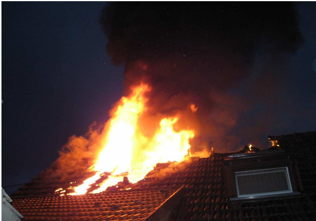
Abb.13: Dachstuhlbrand An der Lache*
