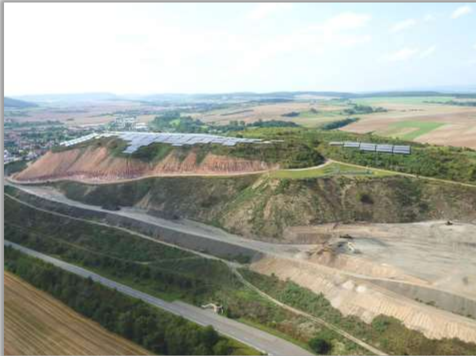
Ansicht der Fotovoltaikanlage auf dem endabgedeckten Teilbereich des Haldenplateaus der Halde Bleicherode
