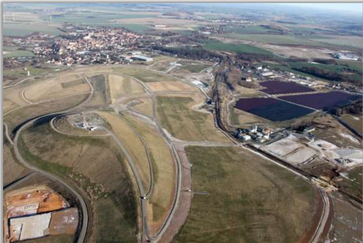
Tagebauverfüllkörper mit dem östlich gelegenen Solarpark, Januar 2012, Foto: TLBA
