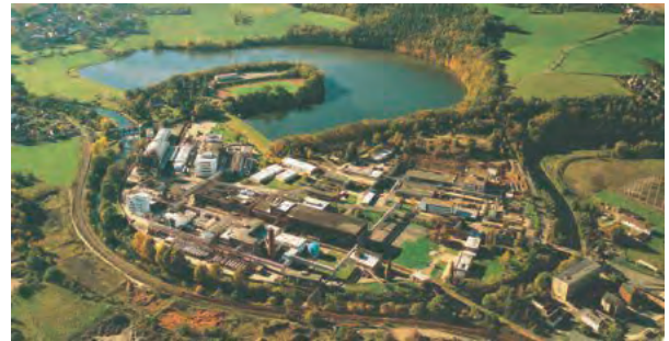
Bild 1: Luftbild des Firmengeländes AKZO NOBEL
