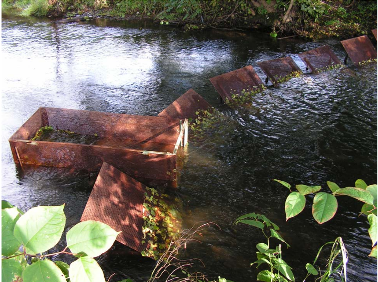
Abbildung 6: Reusenbarriere aus Lochblechen mit noch nicht geschlossenen Lücken
