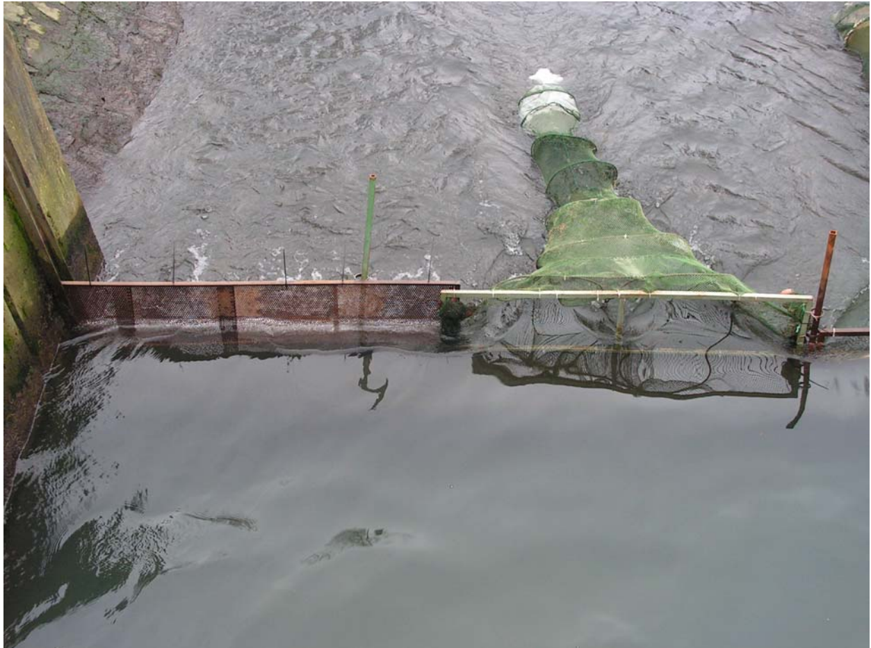
Abbildung 3: Uferseitig montiertes Lochblech
