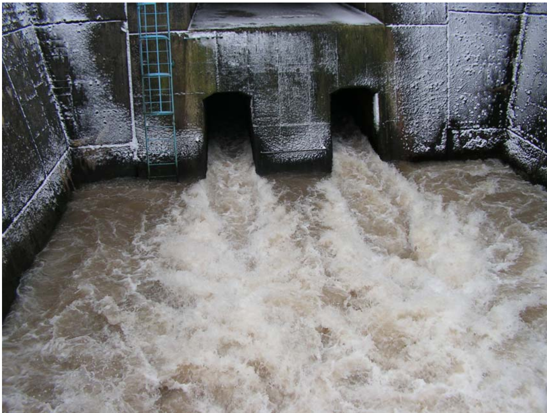
Abbildung 34: Grundablässe bei relativ hoher Wasserabgabe
