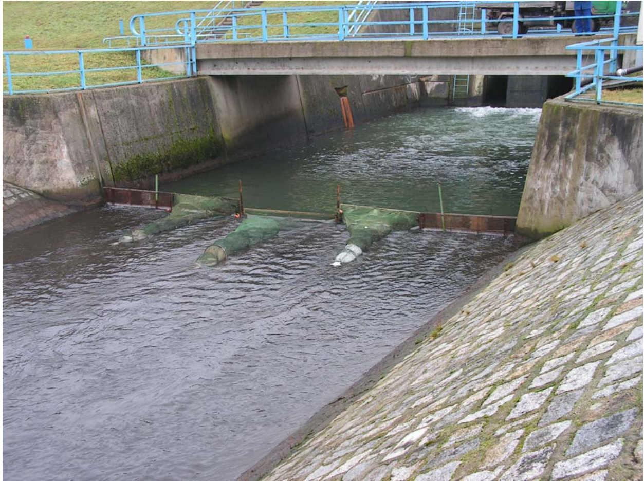
Abbildung 2: Reusenbarriere hinter dem Tosbecken des HRB Ratscher
