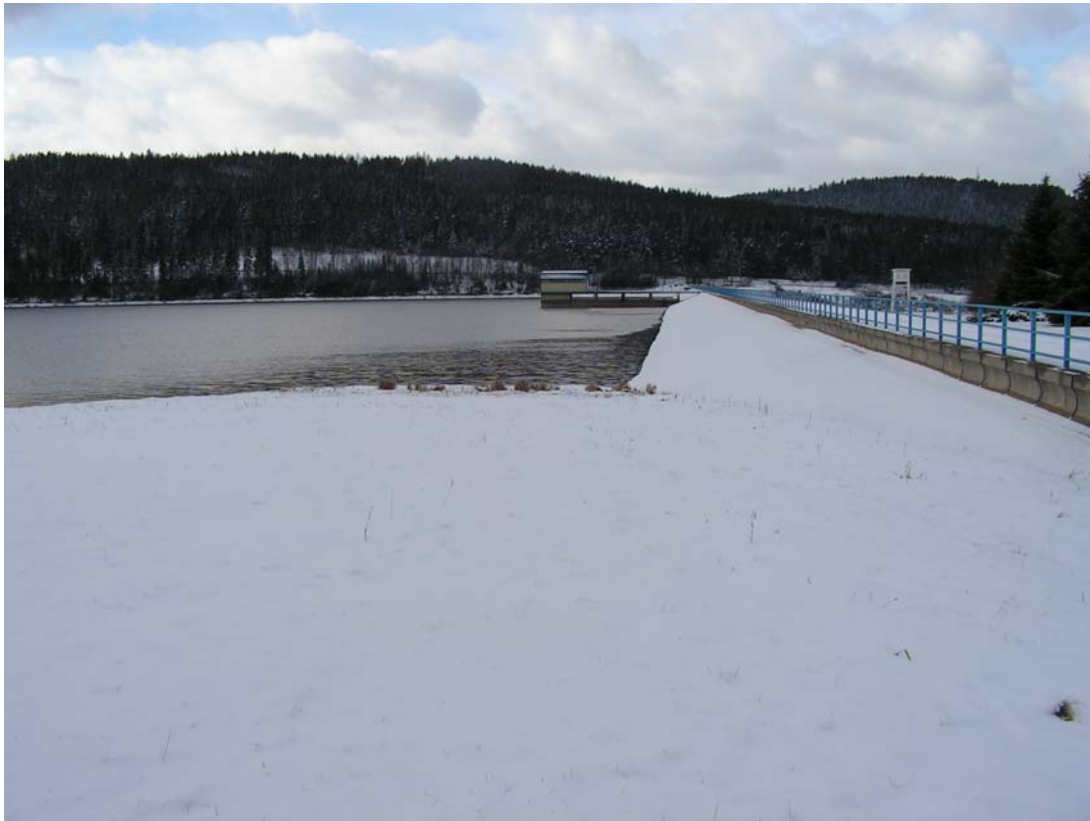
Abbildung 33: Sicht auf das Auslassbauwerk des HRB Ratscher
