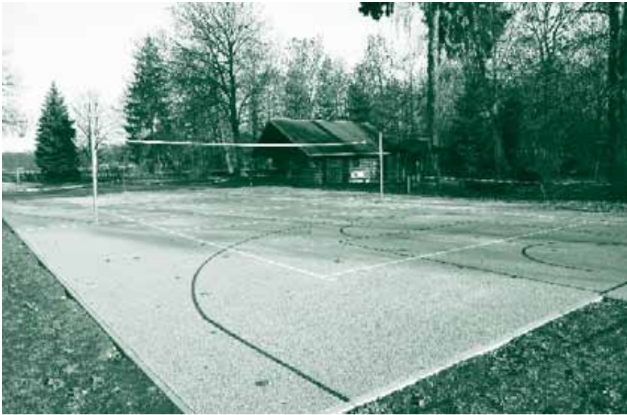
Der Sportplatz mit fertigem Belag und Volleyballnetz.
