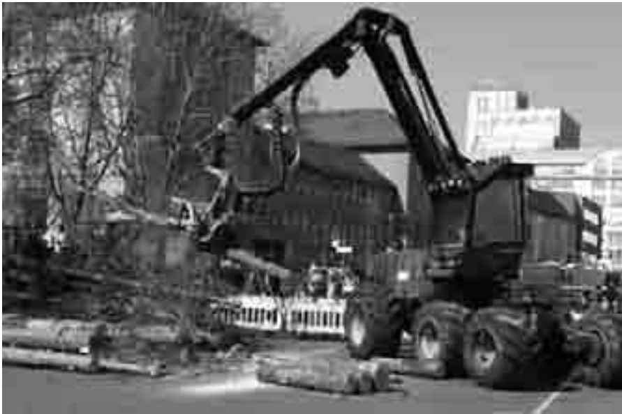
Vorführung des Harvesters durch Maschinenstützpunkt Gebren
