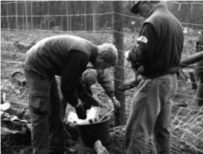
Bau und Erneuerung von Wildschutzzäunen
