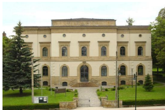
Haus I Zentrales Verwaltungs- und Lehrgebäude mit Aula und Druckzentrum
